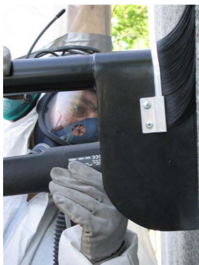
Slipning av fogkanter med vinkelslip Milwaukee AGV 16180 QXC försedd med utsugskåpa från SP.
